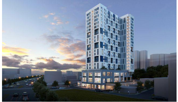
중암동 역세권 행복주택 신축공사
