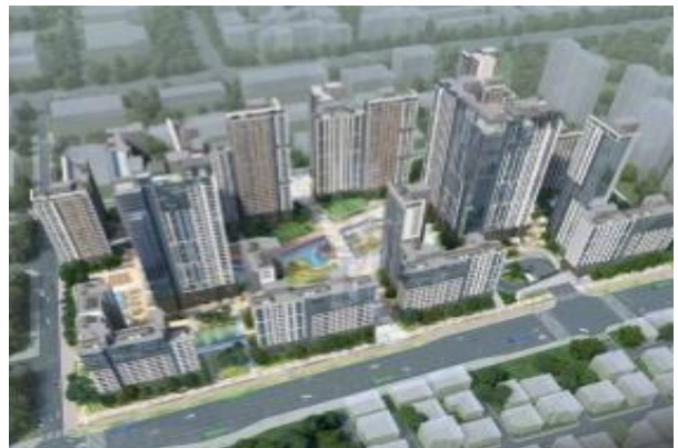
과천주공4단지 재건축정비사업 1,2공구 - GS건설
