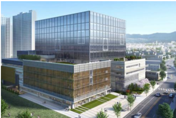
구청사부지 복합건축물 건립공사 - 신동아건설
