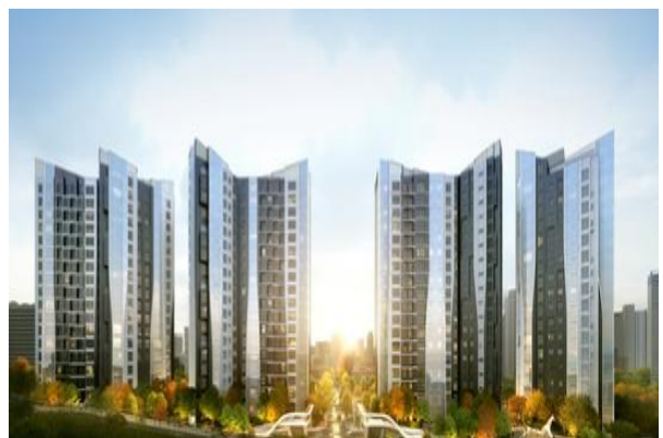
도곡 상호 재건축 현장
