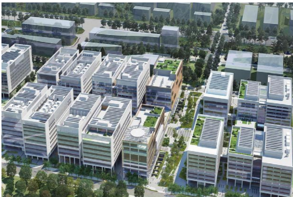
영등포구 여의도동 25-11 복합시설 신축공사- DL이앤씨
