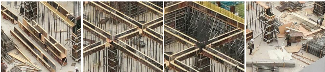
현장 제작 공간 필요 현장 작업량이 증가 양생후 탈형이 복잡 현장 가공이 많다
