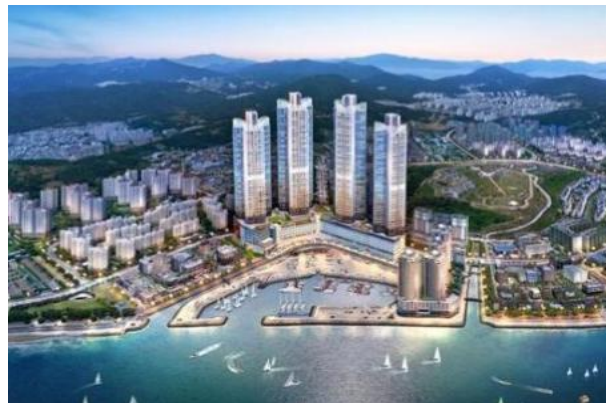
여수 웅천 골드클래스 더마리나 신축공사- 보광종합건설
