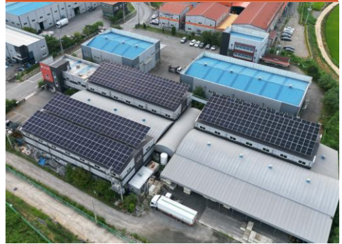
엠텍 태양광 발전소(96.8kW)
