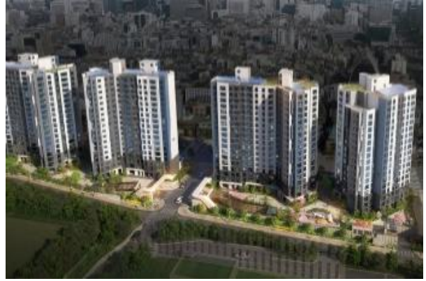
도곡래미안레벤투스 신축공사 - 삼성물산
