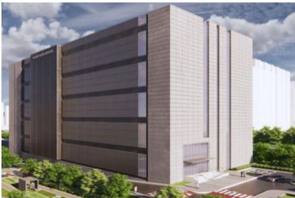
일산 덕이동 데이터센터 신축공사- GS건설
