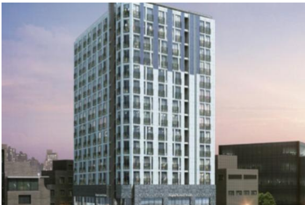
도곡 씨밋 타워 청년주택 신축공사- 강남건영
