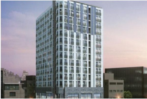
도곡 씨밋 타워 청년주택 신축공사
