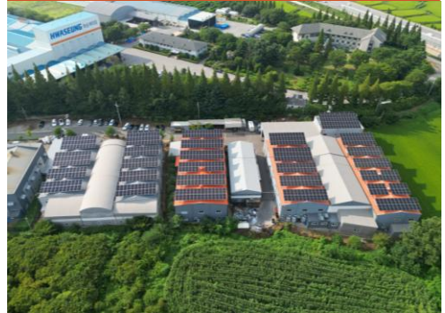
태영금속 & 티와이태양광 (495kW)
