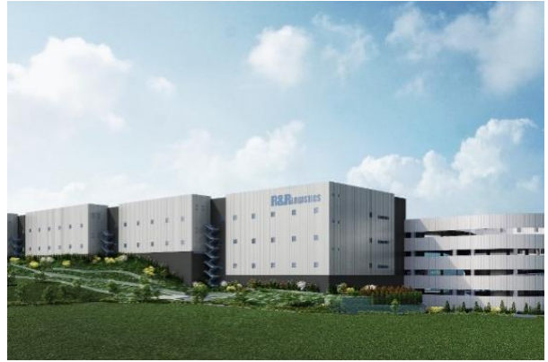
알앤알물류 평택센터 - 포스코건설
