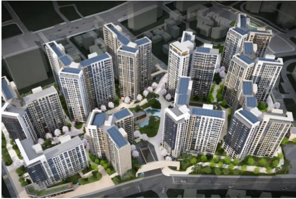
마포자이라첼스 신축공사 - GS건설
