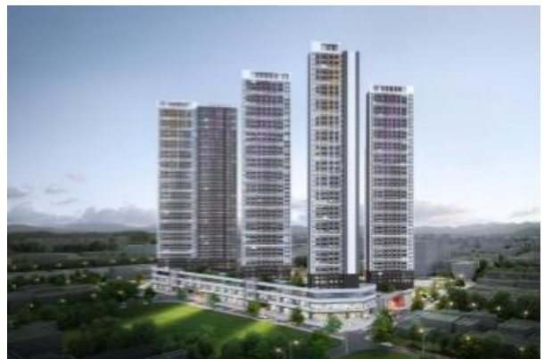
중구 동인동1가 9외 주거복합 신축공사 - 포스코이앤씨
