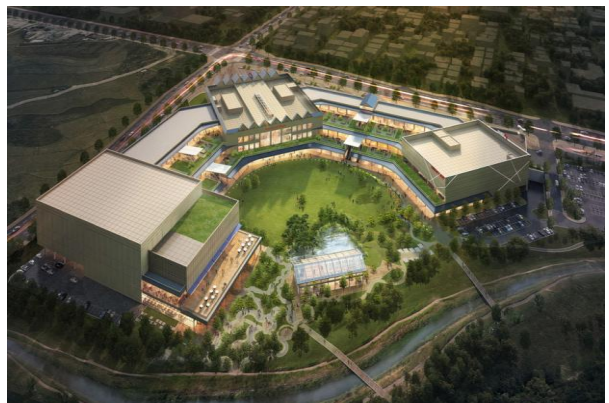
광양 LF 아울렛 신축공사 - GS건설
